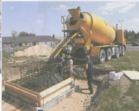
Wylewanie żelbetonowych fundamentów pod pomnik Świadectwo Miłości fot. Piotr P. Ruszkowski
