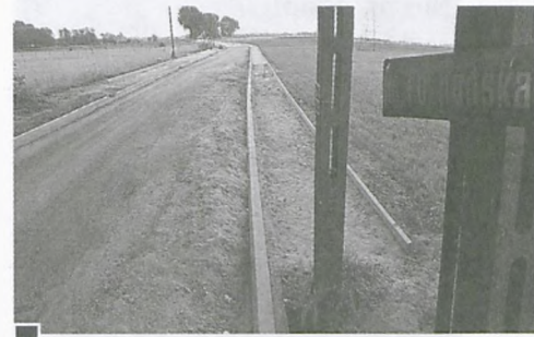
Inwestycja zaczyna się na ul. Poznańskiej od ul. Buczka. Widać przygotowane krawężniki pod budowę chodników po obu stronach nowej drogi fot. Piotr Paweł Ruskowski
