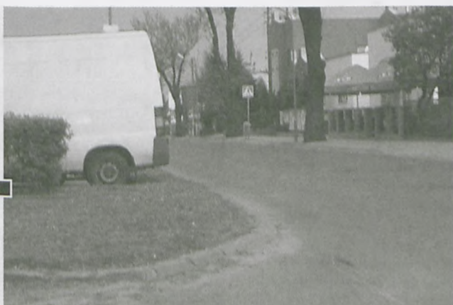
Że zaplanowany parking powoduje, że parkujące zgodnie z przeznaczeniem samochody zastaniają widoczność wyjeżdżającym z osiedla
