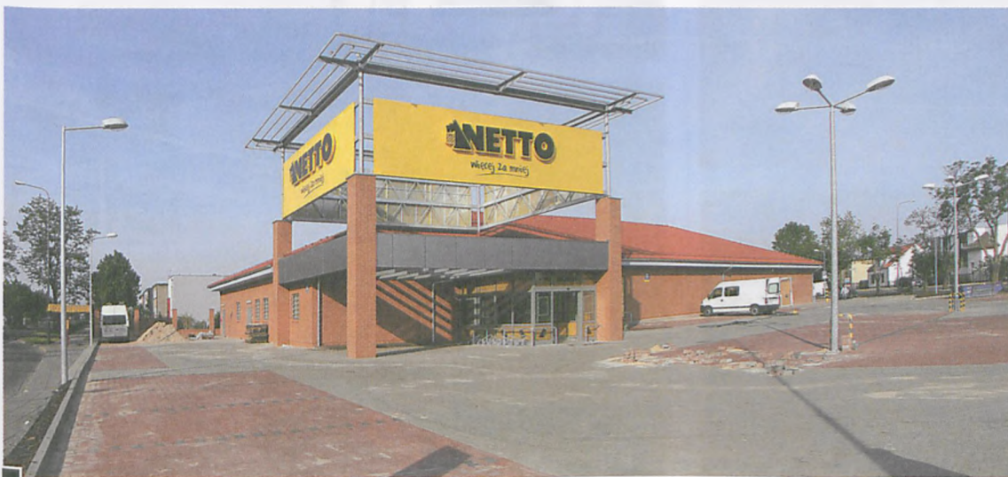
Nowy market na skrzyżowaniu ul. Żabikowskiej i 11. listopada z parkingiem na 60 samochodów fot. Piotr P. Ruszkowski
