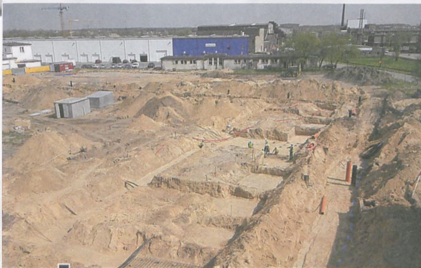
Wykopy pod budowaną z rozmachem kolejną halę Parku Przemysłowego
