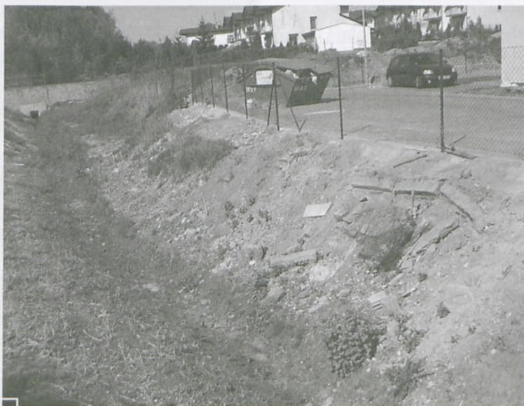
Bałagan i zanieczyszczenie ciek przy ul. Kołtąja fot. Tadeusz Kujawa
